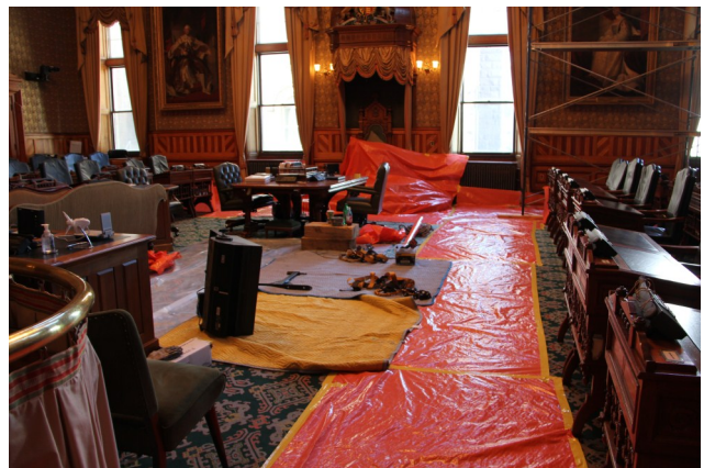
En septembre 2011, des entrepreneurs enlèvent huit gros projecteurs fluorescents dans la Chambre de l'Assemblée.
