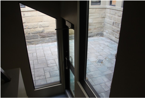
La nouvelle cour, son drainage amélioré, et l'escalier menant à l'entrepôt de la bibliothèque au sous-sol.
